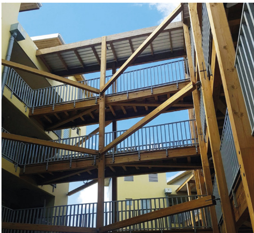
Les Terrasses du Verger, Sainte-Marie / La réunion Coursives BLC Pin | Architecte : A2mpr | Charpentier : BioClimatik
